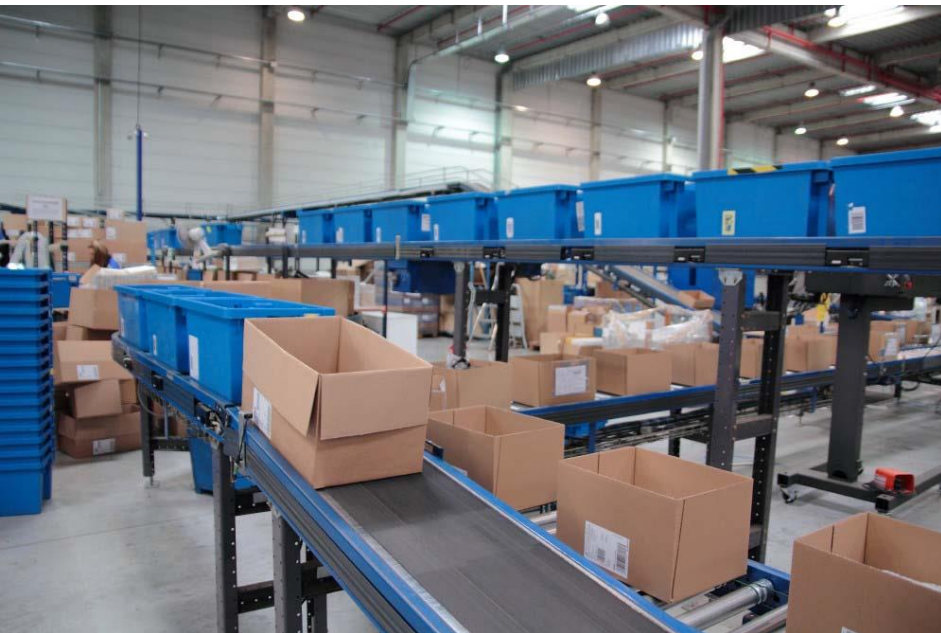
Centre logistique de Saint-Quentin-Fallavier (38)
